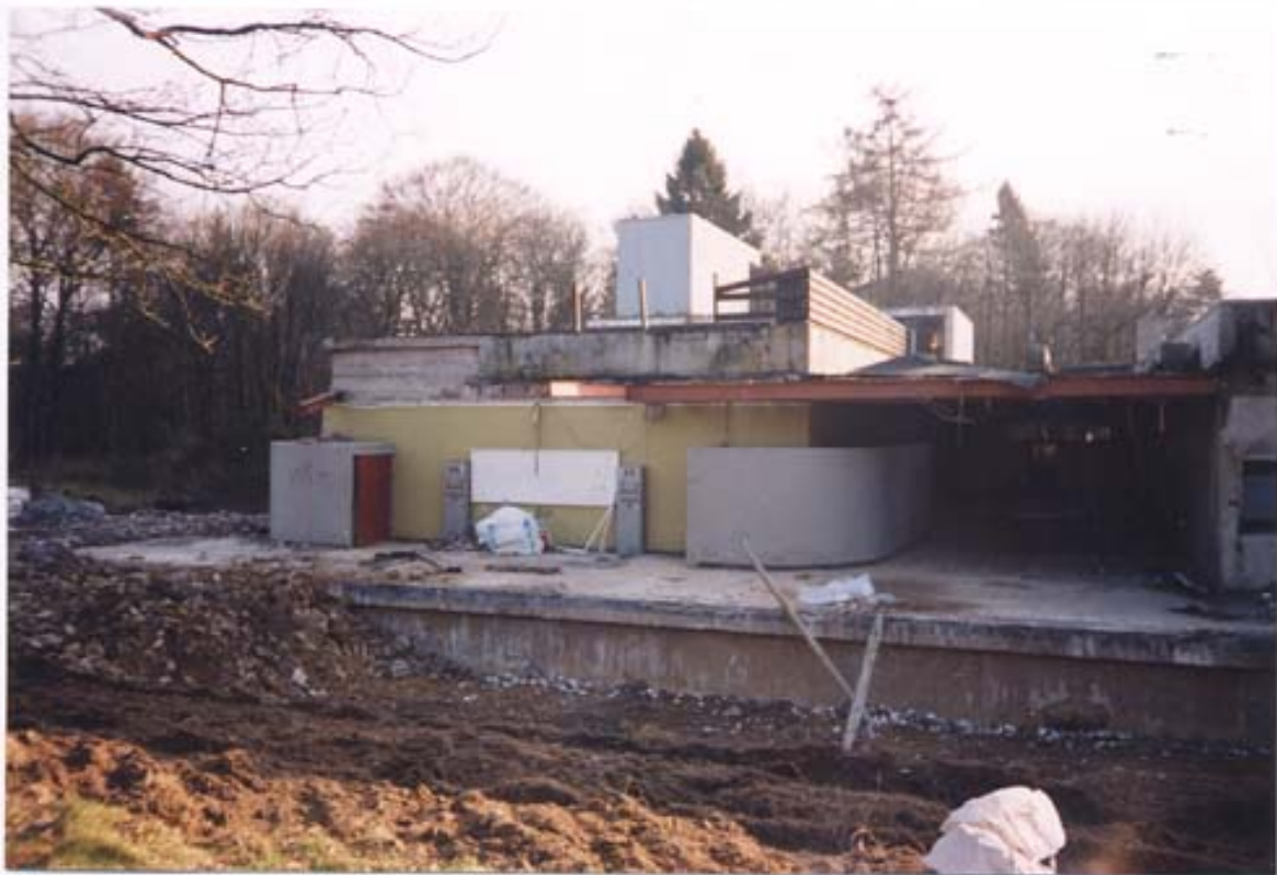
Sloopwerkzaamheden in februari 2002 bij de bunker van de Caesar-bron; foto: stichting Laka
